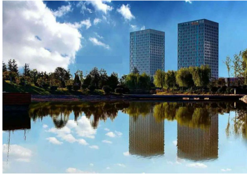
西安センターの所在ビル(左)
